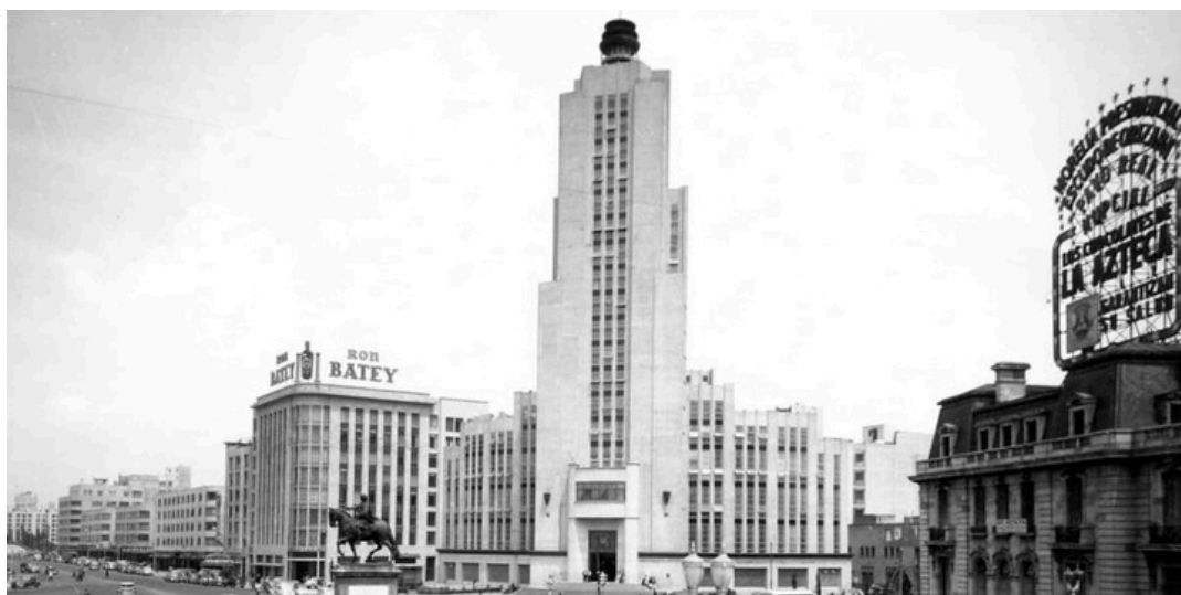
Edificio de La Lotería Nacional: Uno de los primeros rascacielos de la Ciudad de México, este edificio tiene una estética Art Decó en su diseño vertical y sus detalles decorativos.
